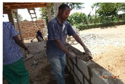
Auch die Maurerabteilung der Berufsschule wird in die Bauausführung einbezogen.
